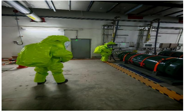
抢救一组穿戴 A 级防护服 + SCBA 进入现场确认有 无人员伤亡，确认泄漏点位，关闭钢瓶阀门
